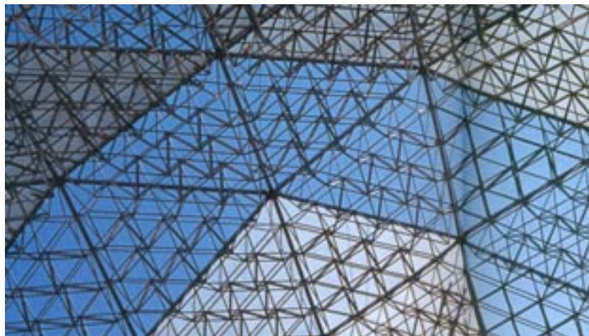
Abbildung 22: Multipolare Tensegritätsstruktur aus Oktaedern und Tetraedern in einer geodätischen Kuppel
