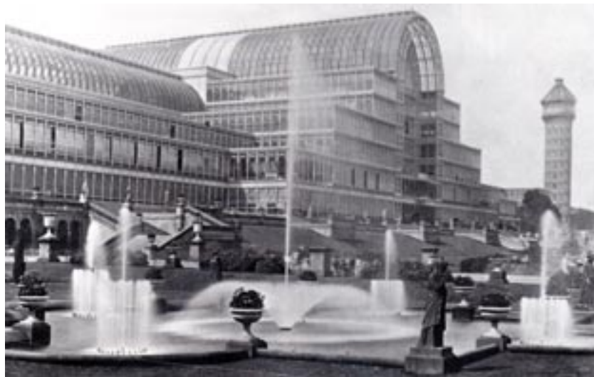
Abbildung 3: Joseph Paxtons Kristallpalast für die Weltausstellung 1851. Das neue Material zeigt sich selbstbewußt in der Form.
