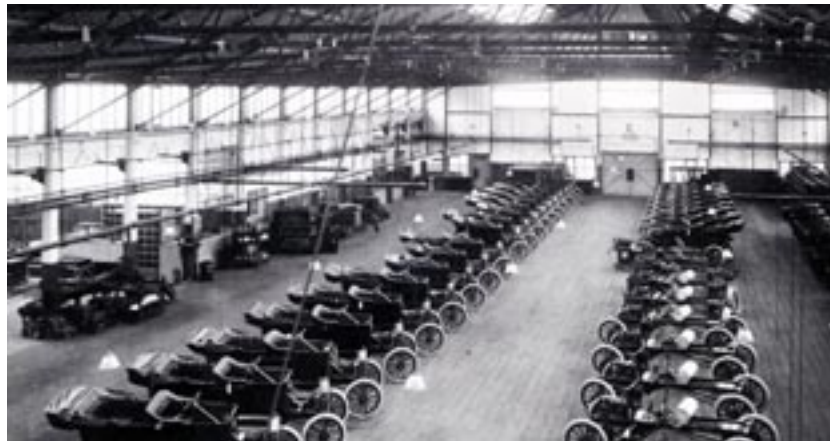
Abbildung 7: Eine neue Dimension der industriellen Massenfertigung. Der Ford Model T in Produktion in der Trafford Park Factory.
